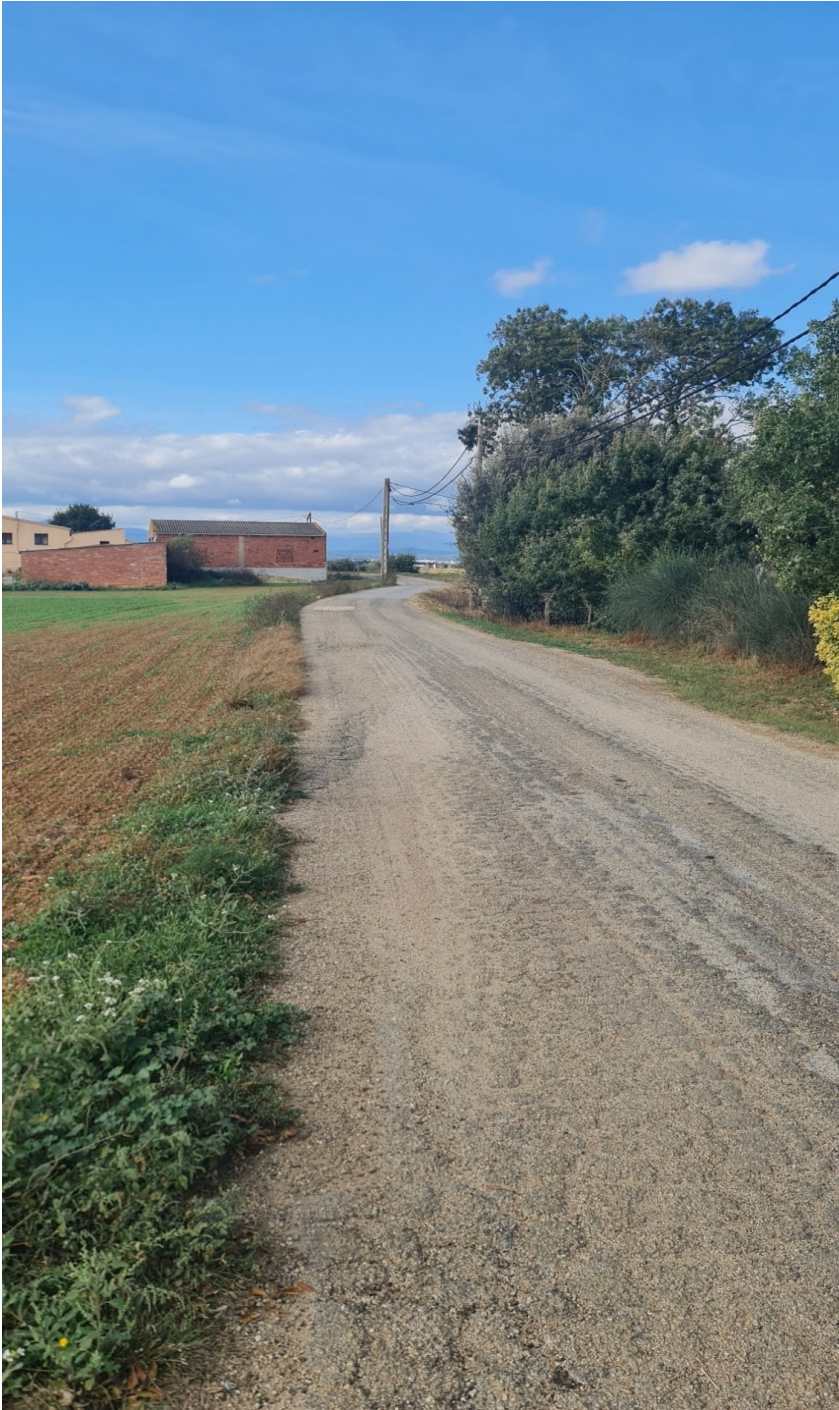
PK 0+500 Serveis tècnics municipals. Cassà de la Selva, novembre de 2025
